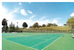
スポーツ施設
